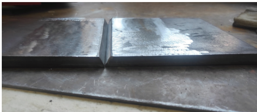
Рис. 1. Пластины под сварку
