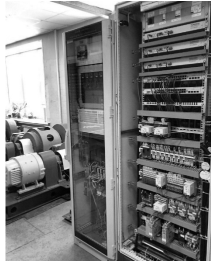
Рис. 2. Опытный образец автоматики управления режимами электростанции малой генерации
